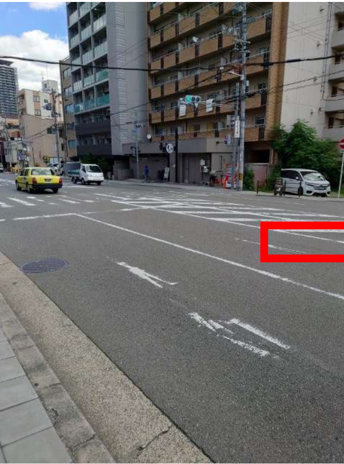
舟橋町交差点 横断歩道3ヶ所 停止線 A
